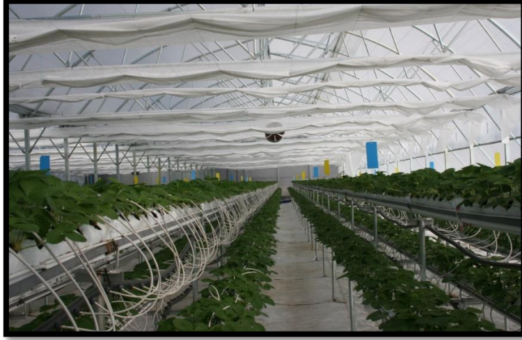
Topraksız Çilek Sera Tesisi Topluca Köyü/BARTIN
